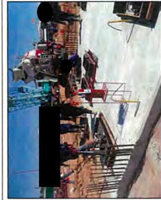
Concrete casting for HRSG #71 pedestal
